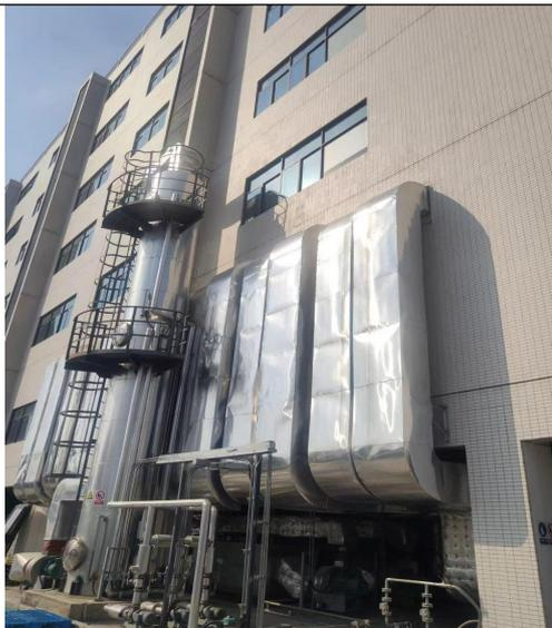
极片车间的废气处理设施（二级冷凝回收处理+水喷淋）
